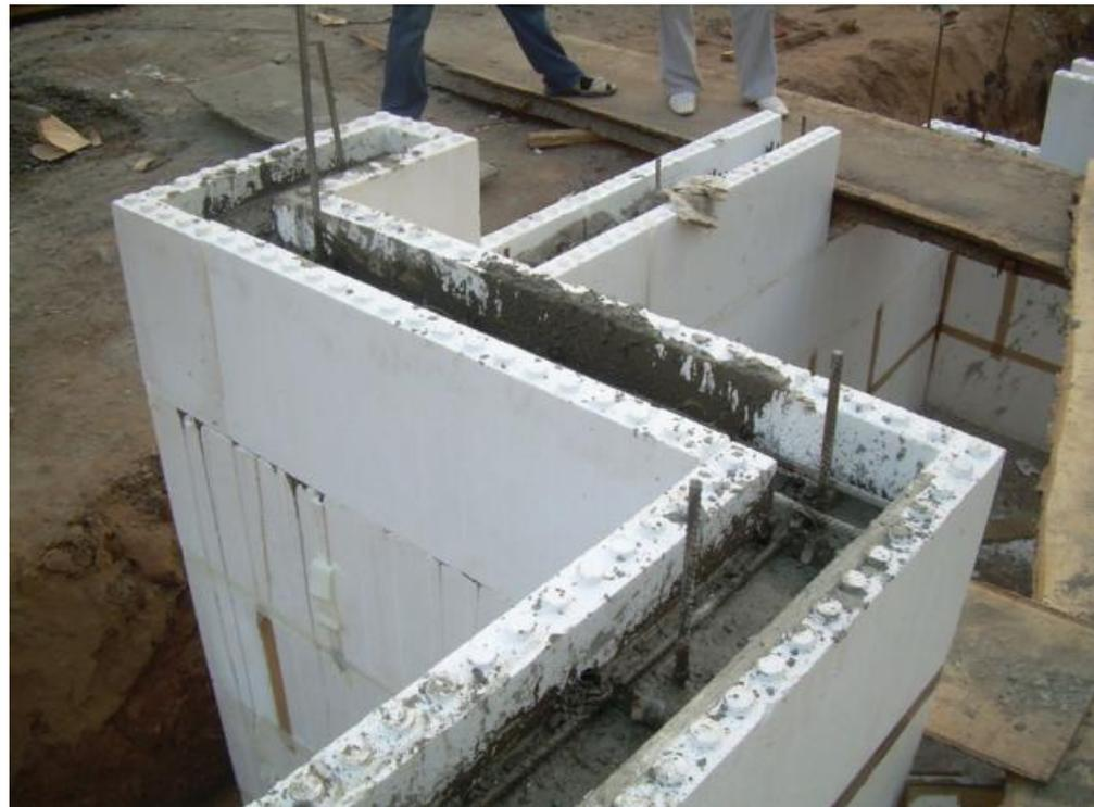
Толщина конструкции – 30 см, из которых 15 см – монолитный бетон и 15 см (10+5) – пенополистирол
